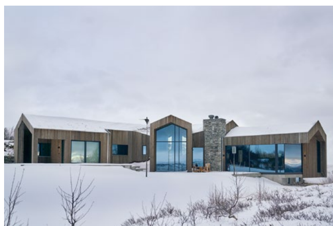
Hytta er utført i en kledning av malmfuru påført jernvitriol, og alle vinduer har aluminiumsprofiler for å redusere vedlikeholdet til et minimum. Nivåforskjeller tilpasset tomten gir et spennende og moderne arkitektonisk uttrykk.
