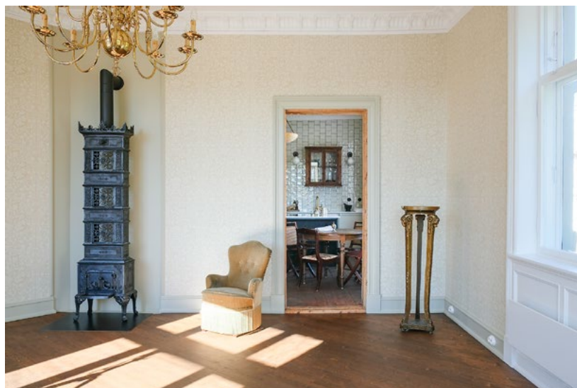
Den lyse hjørnestuen, med et tapet som løser opp veggens kompaktet. I dette rommet ble hvert gulvbord demontert, før bjelkelaget ble forsterket, og gulvbordene lagt tilbake.
