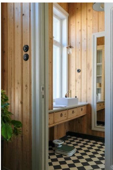
Innredningen i anretningen ble bygget om til å bli servant i badet. Opprinnelig panel ble demontert og merket før rommet ble bygget opp med våtromsstandard, og panelene remontert.
