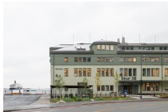
Skur 38 sett fra bysiden med nytt inngangsparti og fargesetting.
