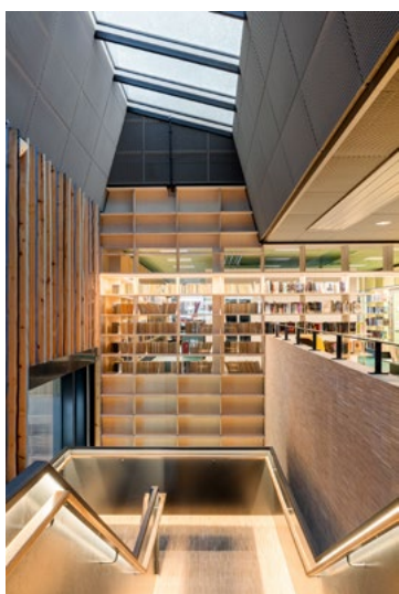
Trappeløp med bokhyllevegg fra 1. til 2. etg. utført i lyst bjerkefiner.
