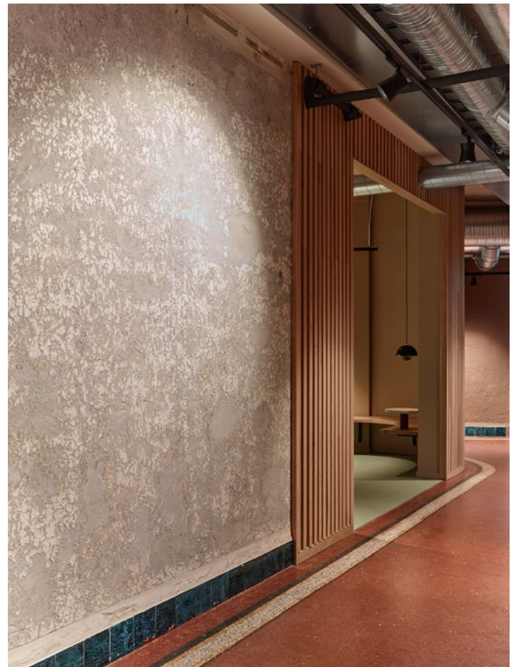
Patinert vegg og terrazzogulvet som ble funnet godt gjemt under gulvfliser og teppefliser.
