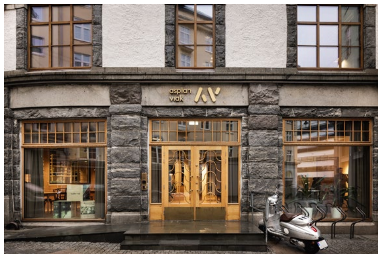
Arkitekt har i dag tilbakeført fasaden tilnærmet slik den var originalt, og bygget har fått tilbake sin prakt og kontakten med det myldrende livet på Torgallmenningen.
