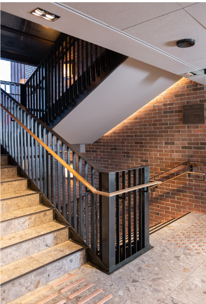
Hovedtrappens spesialtegnede rekkverk i varmvalset stål og tre. Det ble vektlagt en gjennomgående detaljering og materialholdning for taktil og visuell merking.
