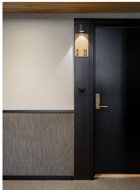
Skilting beboerdør: Skiltingen er basert på Kartverkets H-nummer. Med stadig flere som handler på nett, er nummering av leilighetene viktig. For å skape en illusjon av bredere inngangsdører er skilt, lampe og ringeklokke montert på et sidefelt. Her er det også plass til beboers eget navneskilt.
