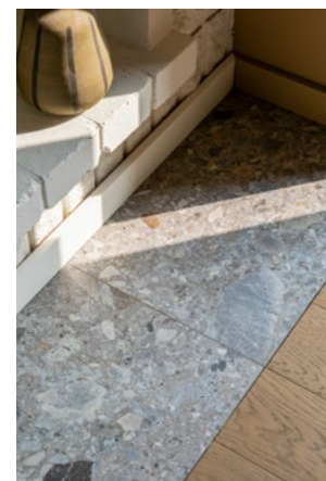
Foran peisen ble det lagt en stripe med varmebestandige fliser. Det ble lagt flid i pene overganger mellom fliser og parkett.
