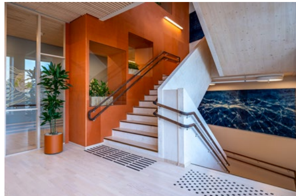
Hovedtrapp i massivtre med møbelvegg i gjennomfarget oransje MDF. Vindu i møbelvegg gir siktklinjer og dagslys fra trapperommet til korridoren.
