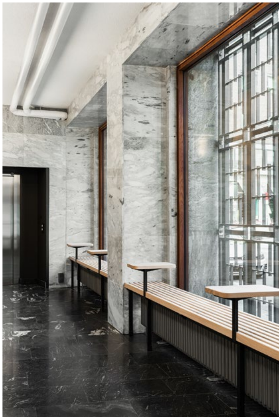
Marmorsalen har opprinnelig marmorfliser på vegg som er renset og reparert, og spesialbygde sittebenker i vindussmygene.
