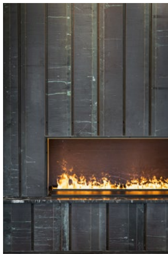
Peisen på plan 2 er kledd med gjenbrukskobber fra fasaden. Kobberet ble valset ut og knukket på nytt til kassetter.
