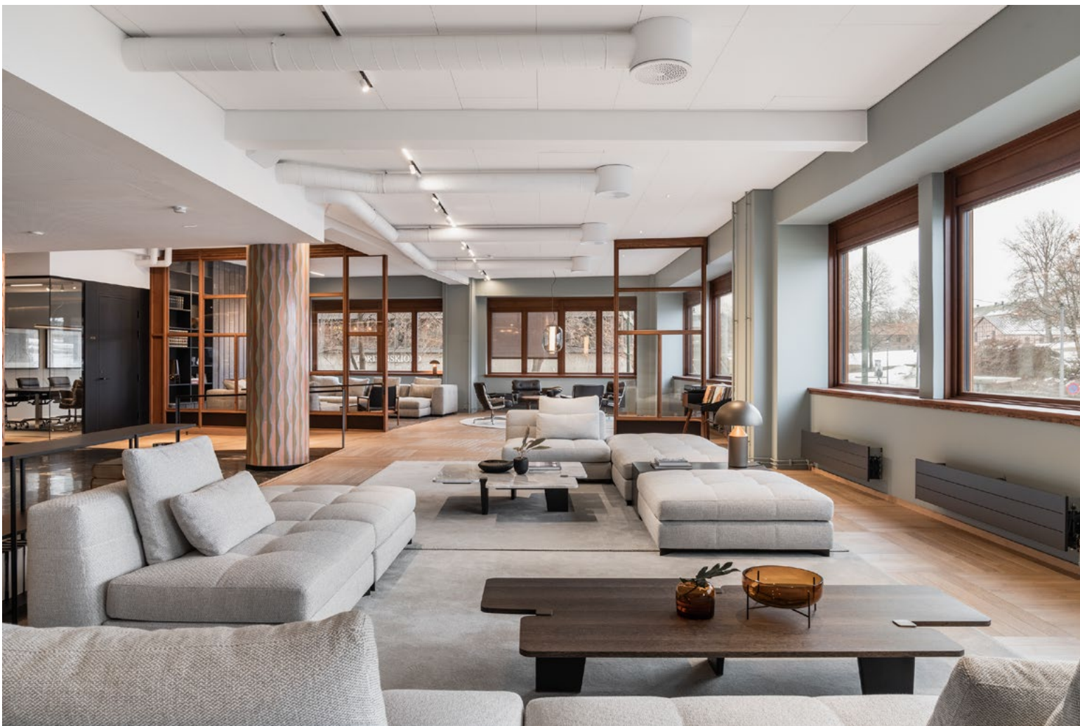
For å kunne se ut av vinduene når man sitter i loungen på plan 2 er gulvet hevet. Himlingen er åpen for å gjøre det mer luftig, noe som fordret omstrukturering av ventilasjonen. Herfra ser man deleveggene av gjenbrukte teakvinduer.
