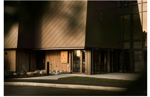
Beckerwyc House – hovedinngangen.
