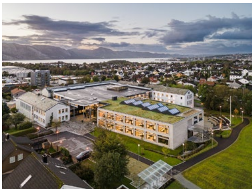
Nybygget kobler seg på den eksisterende bygningsmassen på en logisk og intuitiv måte som ivaretar menneskeflyt både inne og ute.
