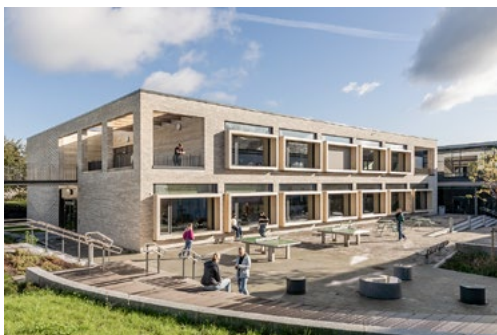
Nybygget er en massiv trekonstruksjon med teglstensfasade.
