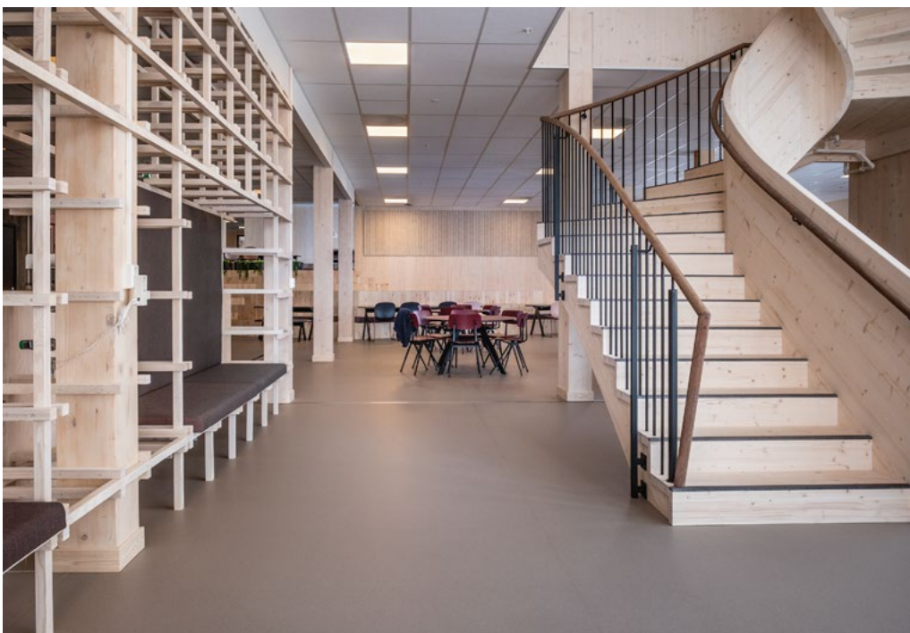
Kantinen har en delvis skjernet sitteløsning mellom serveringen og sitteplassene for å skjerme visuell og fysisk støy. Gjenbruk av trematerialer fra Svea-gruvene finnes i trapper og sittebenker.
