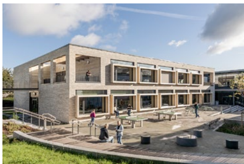
Nybygget er en massiv trekonstruksjon med teglstensfasade.
