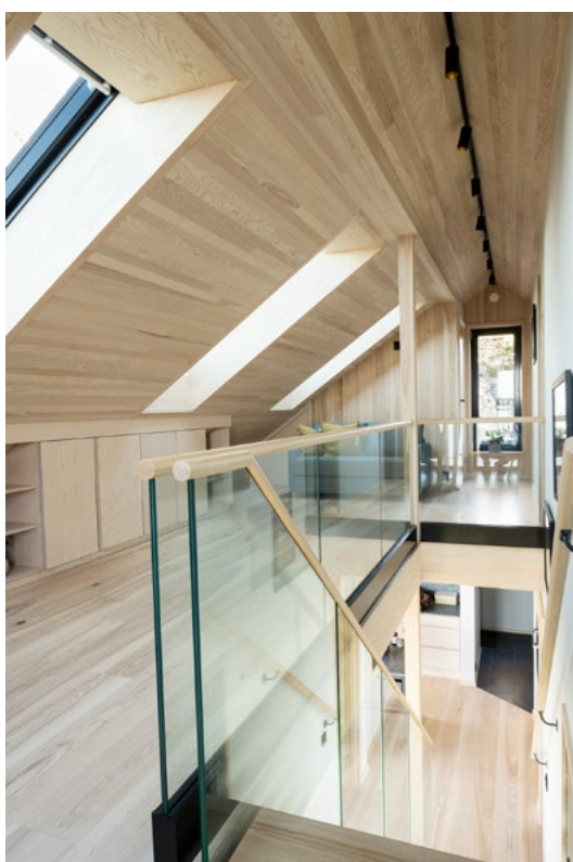
Med takvinduer som slipper inn masse lys og glassrekkverk rundt trappen, gjør at rommet beholder en god romfølelse, tross det skrå taket. Oppbevaring langs hele kneveggen gjør at vanskelig plass med lav takhøyde, får nytte og gir god oppbevaring i 2. etasje.
