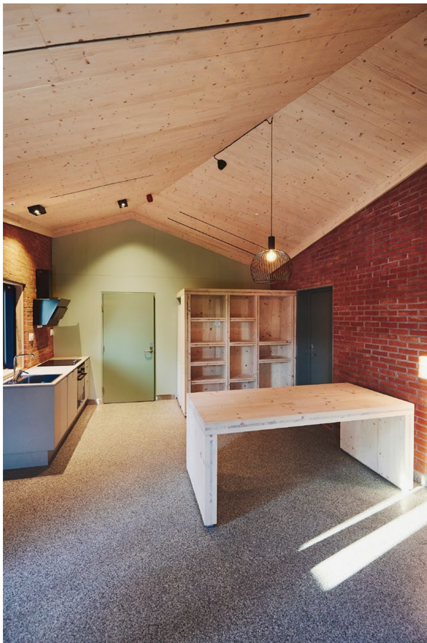
I motsetning til konvensjonelle bygg, har miljøtiltaket vært å lage boliger som ikke kan demonteres, for å unngå at man stadig må bygge dem opp igjen. Det har for eks. ført til att fugemassen mellom mursteinene er sement og ikke kalkbasert.
