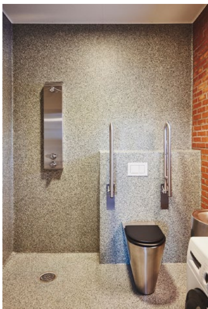
Badene er minimalistiske og robuste. Gulv og vegger er behandlet med Acrylicon.
