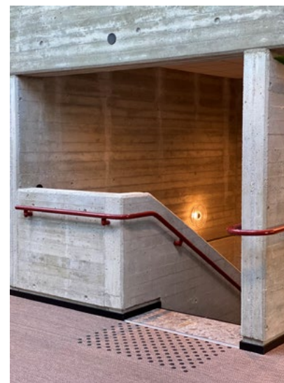
Den eksponerte betongen går igjen i bygget som en del av byggets bærende elementer. Ny belysning er lagt i tilbaketrunkede nisjer i himlingen for å vaske betongen med lys og få den grove teksten til å synes bedre.
