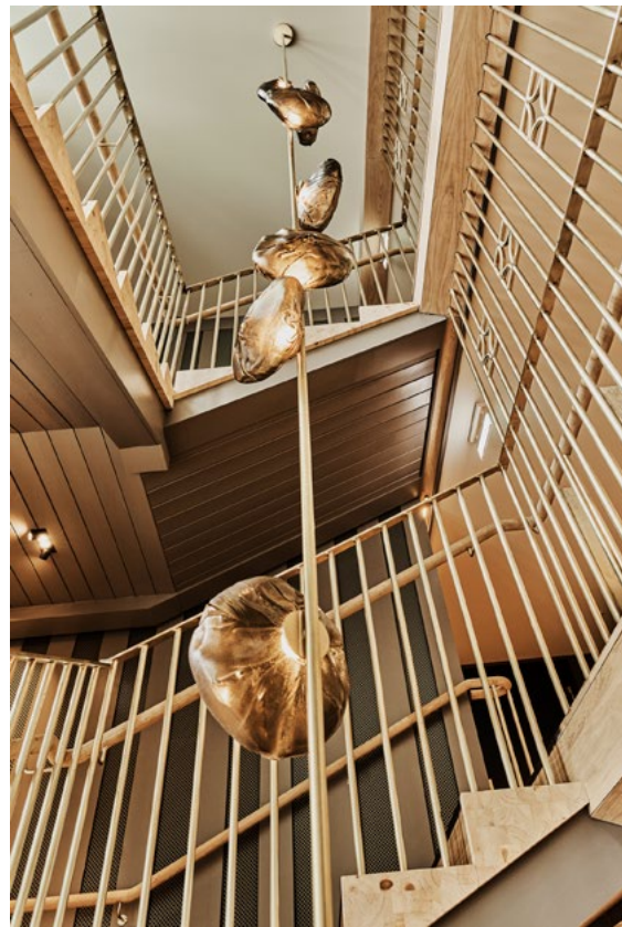
Nytt universelt utformet trapperom, med spesialdesignet Bocci-lampeinstallasjon.
