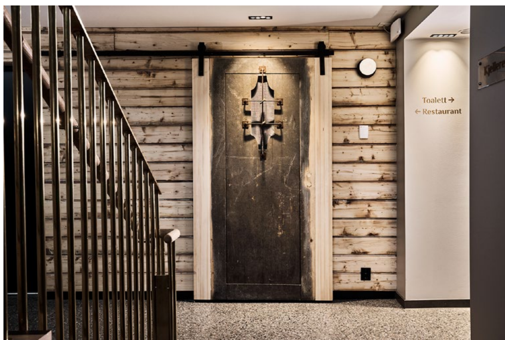
Kjelleretasjen med gamle originale dører ombygget til skyvedører, og tømmervegger fra det gamle trapperommet til veggkledning.
