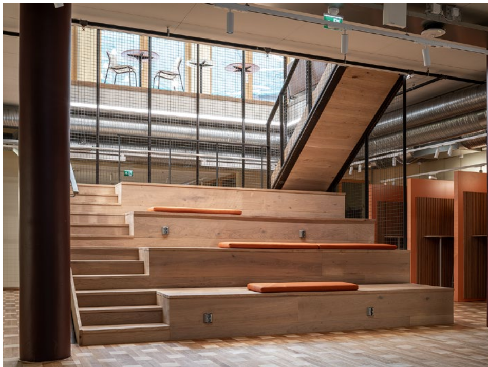
Amfiet sett fra U1. Hovedformålet med en åpning er å få dagslys ned i en høy underetasje som var veldig godt egnet til møteromsenter og fellesarealer. Denne åpningen var der fra husets opprinnelse, men var blitt lukket en gang i 90-årene. Ved bruk av t-baneskinner i amfiet og en annen trapp sparte man 1,2 tonn CO 2 .
