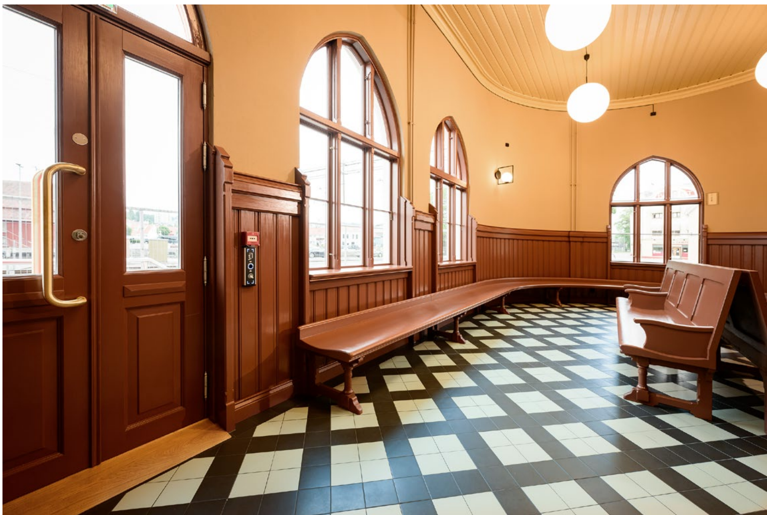
Venterommet består blant annet av tilbakeført brystningspanel og plassbygd sittebenk langs yttervegg. Midten av rommet består av plassbygde sittebenker med armlener. Gulvet består av fliser for høyere slitasjestyrke og er lagt i historisk mønster.
