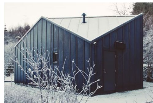
Den lille eneboligen ligger i området Pilehagen på Karmøy, og er utført i massivtre, med synlig treverk i interiørene.
