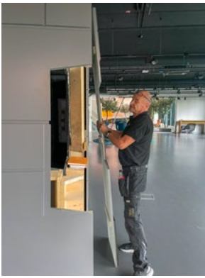
Prosess: Valchromat og MDF-paneler fra Engineerium ble demontert og transformert til konkave profiler til front på fast innredning.
