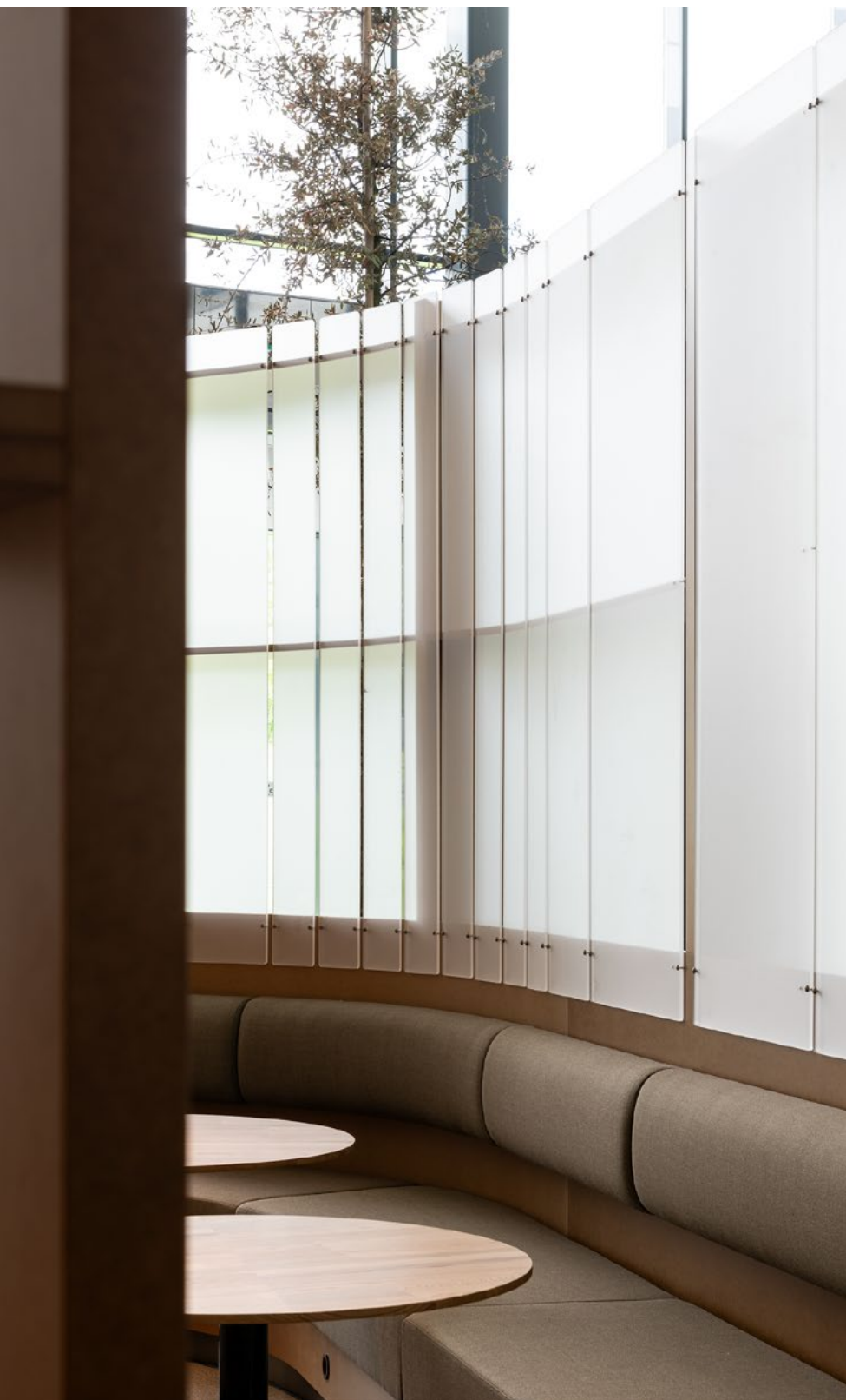
Fellesareal: Kontoretasjene i Snarøyveien 20 sto fullt møblert med arbeidsbord med utdaterte bordskjermer i akrylglass. Fordi de ikke har de lydabsorberende egenskapene man ser etter i dag, så man etter nye måter å bruke bordskjermene på. Noen lever videre som skillevegger for visuell skjerming i kantinen der materialets kvalitet og uttrykk kommer mer til sin rett.
