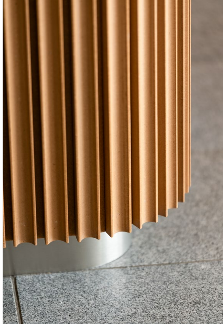
Fellesareal: MDF-profilene som ble frest ut av veggpaneler fra bygget gir nå karakter og identitet til interiøret.
