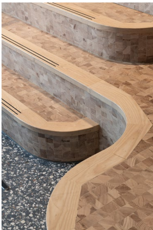
Amfiet er bygget opp av avkapp fra trappeproduksjon fra REWO.
