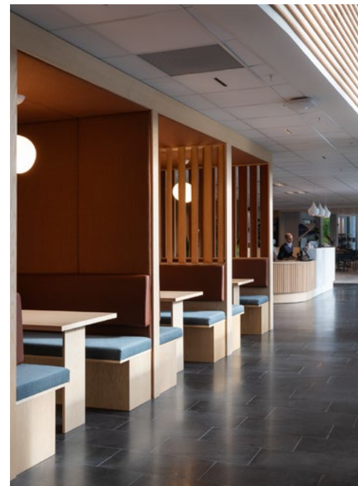
Plassbygde sittebåser fra kontoretasjen ble demontert, supplert og reetablert i inngangspartiet.
