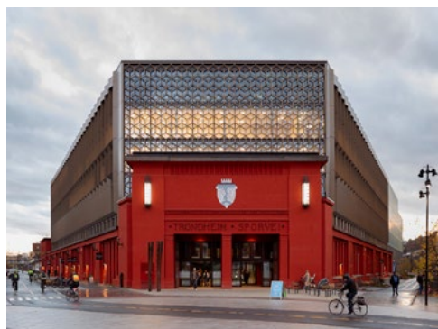
Hovedinngang som er en oppgradert versjon av den opprinnelige fasaden.
