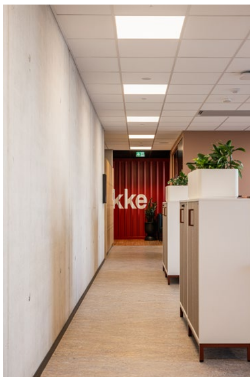
Ubehandlete betongvegger er «fredet» og oppbevaring er gjenbrukt. Skap har fått nytt liv med nytt understell, lakkerte grep og folierte fronter. Veidekkes studio skimtes der veggene har fått containerkledning.
