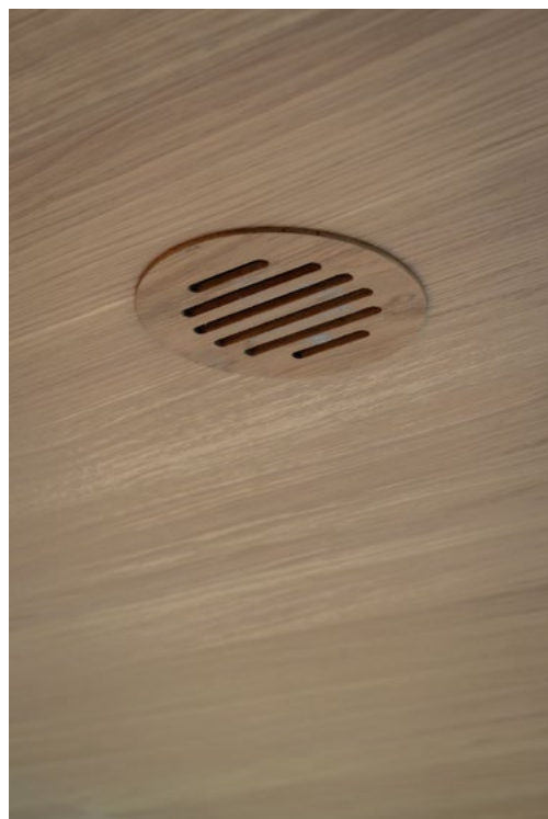
Detalj ventilasjonsrist i eikehimling.
