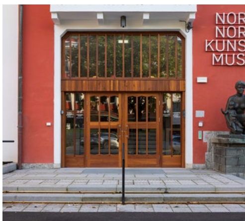
Hovedinngangsdøren i teak ble gjenfunnet hos en privat eier, restaurert og manglende vindusdeler rekonstruert.
