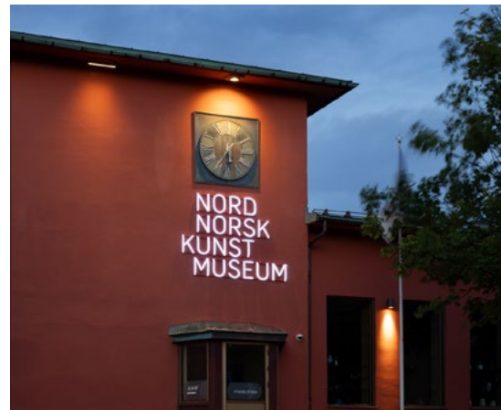
Byggets fasader ble tilbakeført og fargesatt i henhold til Bodø kommunes estetikkveileder for Storgata.
