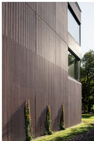
Sporene i fasade avtar i tetthet for hver etasje og tilfører et relieff i den fargede betongen.
