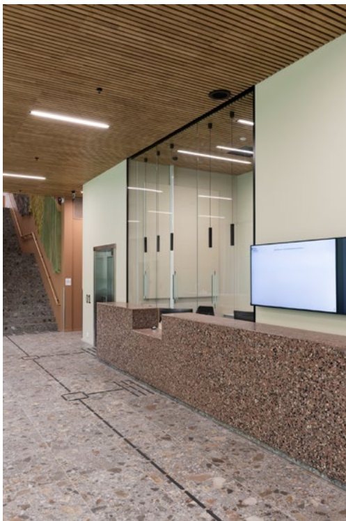
Ekspedisjonen er støpt med samme betong og tilslag som fasaden, men overflaten er polert, noe som gir betongen en glatt overflate og nytt uttrykk i interiøret.
