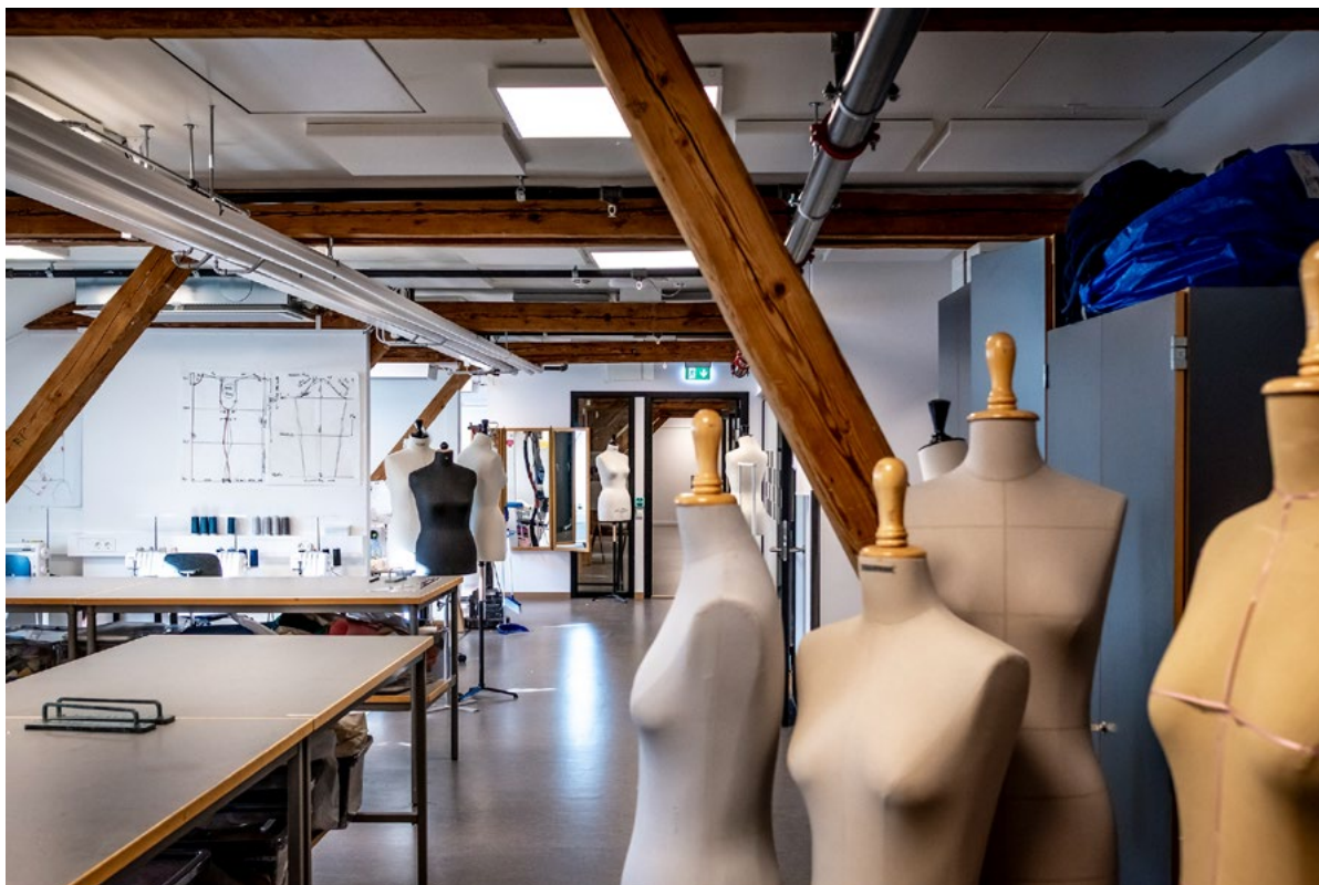
Mote- og tekstilverkstedene i 4. etg. har beholdt eksisterende gulvbelegg som var i god stand og kun supplert med nytt der vegger er fjernet. Arealet er fullsprinklet og det gjorde det mulig å beholde treverket i den bærende konstruksjonen ubehandlet.
