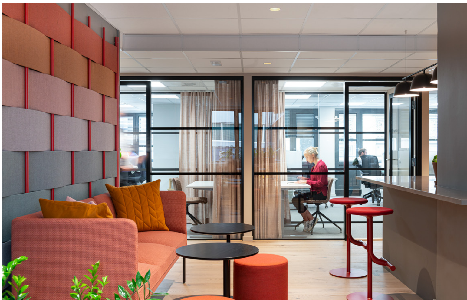
Sosial sone med spesialdesignet dekor/akustisk vegg. Veggene er trukket i tekstil Re-wool fra Kvadrat laget av resirkulerte materialer.
