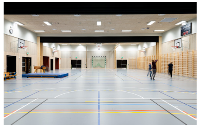
Gymsalen kan deles i tre saler. Godt inneklima og god akustikk oppnås ved bruk av trespiler med aksustisk duk på vegger, treullsement i himling og sportsgulv. Garderober er knyttet til gymsalen via trapper som kan oppleves fra korridoren gjennom små gløtt i den ellers tette kjernen.
