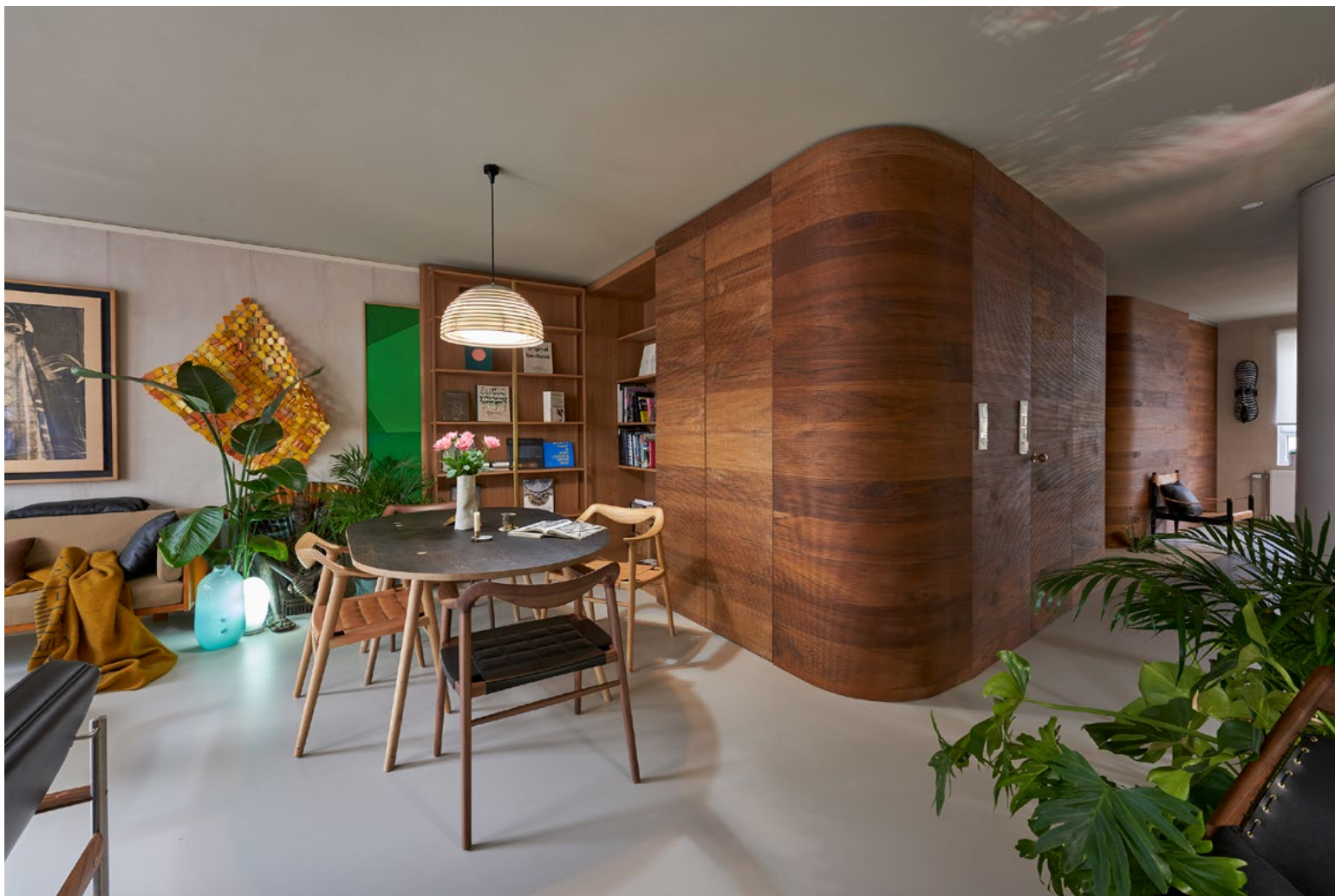
Mellow er et påstøpsmateriale i tre sjikt, der siste lag sprøytes på tynt som en «kakeglasur». Gulvet er usedvanlig fleksibelt og fløyelsmykt. Det bærende designelementet i leiligheten er vegger som er kledd med trefiner i organisk form.
