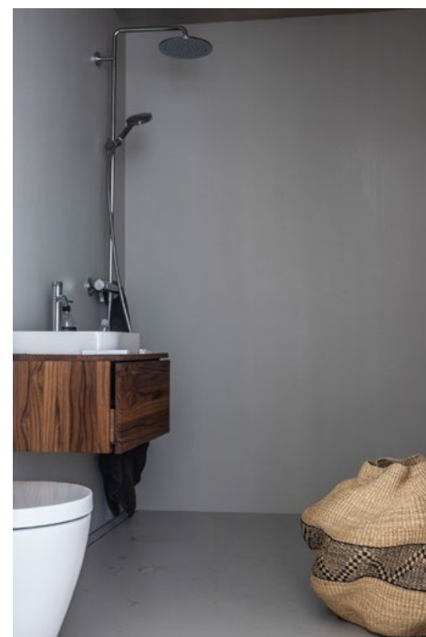
Bad og vaskerom er praktisk og designmessig en forlengelse av det organiske «skallet» i treverket. Fugefritt Mellow fra gulv til vegg – ingen forstyrrende linjer og skjøter, bare total arkitektonisk ro.
