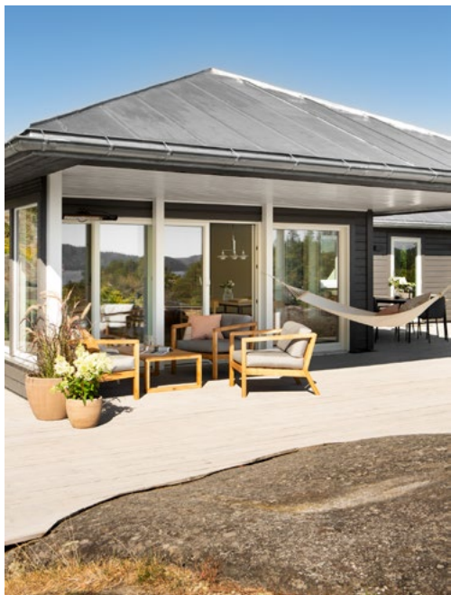
Utendig har hytta blitt malt om, og fått båndtekket zinktak. Uteplassene følger sola rundt hele hytta.
