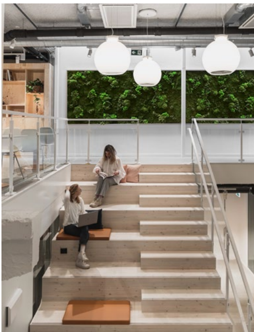
Atriumstrapp laget av gjenbrukt materiale fra Tøyenbadet.
