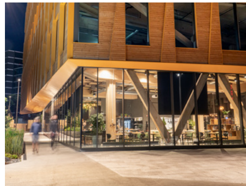
Eksteriør med restaurant i første etasje.
