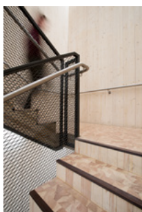
Trappeoppgang i massivtre med kubbegulv.
