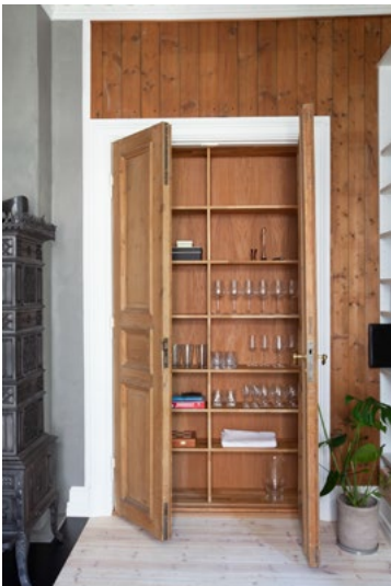
Mellom gangen og biblioteket ble blant annet en dobbeltfløyet dør blendet av – og har blitt transformert til et praktisk skap for glass og servise.
