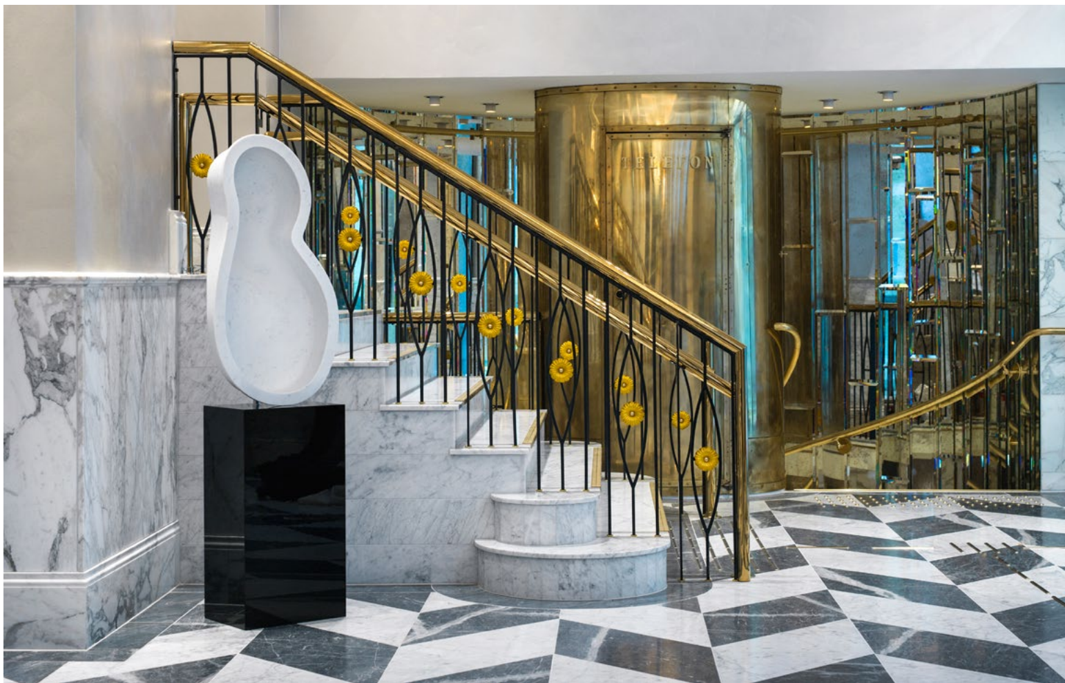
Korsmotrappen – original telefonkiosk integrert i søyle, kledd i messing. Spellpaneler erstatter glassfibertapet. Messingneser lagt til i 2019 for universell utforming.
