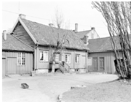
I prosjektet «Rehabilitering og redesign», inngikk vi et samarbeid med stiftelsesstyret i Biermannsgården, Maridalsveien 78.
