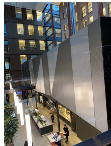
Fasaden på kartsenteret er kledd med aluminium kompositplater fra Stac Bond i to ulike farger med ulik glans for å skape en variasjon i overflaten.
