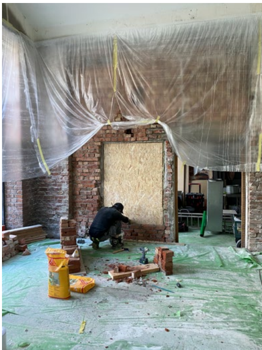
Tetting av hull i vegger med tegl fra KA13. Mad/Sane. Foto → Ine Stokka
