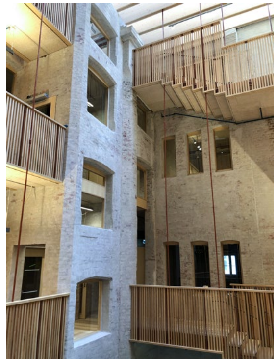
Pressens hus (IARK): Bevaring av konstruksjoner, detaljer og foredling av gamle overflater gir karakter og stemning. Prosessfoto → Thea Røhr
