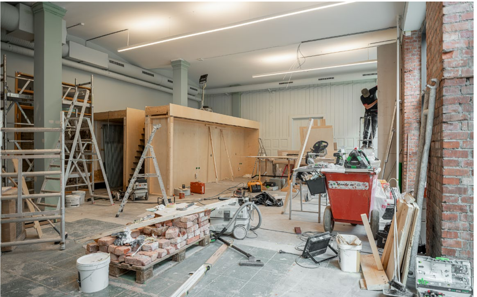
Byggeplass i Pilestredet 27. I lokalet mot gaten er kun benyttet ombruk av bygningsmaterialer, innredninger og møbler. Mad/Sane. Foto→Kyrre Sundal
