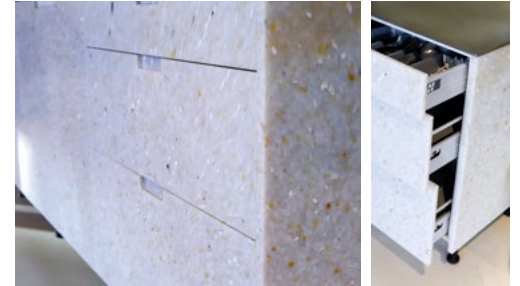
Kjøkkenfronter i smeltet plast. Platene er omsmeltet plastavfall fra blant annet spoler til symaskin, 3D-printer filament og liknende. Mad/Sane. Foto→Sindre Rosness, Norwegian Trash
