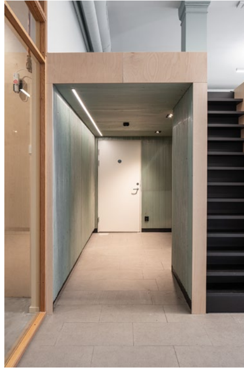
Garasjekledning i rustent bølgeblekk ble forrom til toalettene. Mad/Sane. Foto→Kyrre Sundal
