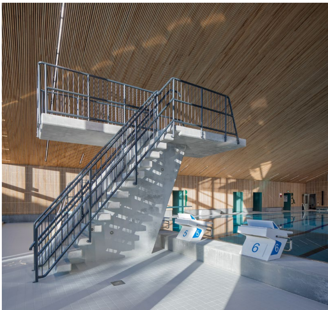
3 m stupeplattform i betong med svevende trinn tar opp formspråket til bygningskroppen. Betongen slipes slik at sklisikkerheten ivaretas.
