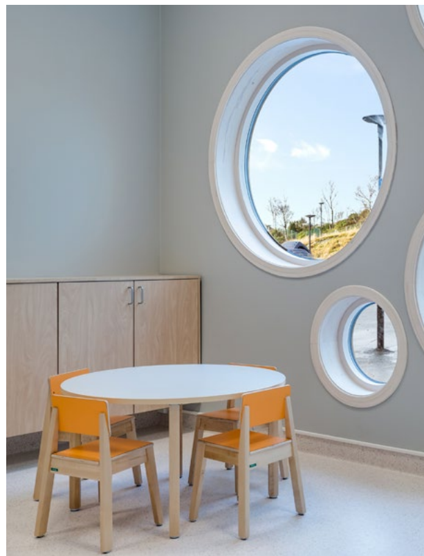
På grunn av kravene til daglys og utsyn i lekearealet måtte man etablere nye vinduer for å få arealet godkjent. Under etableringen av disse vinduene ble det et avdekket et vindkryss i ytterveggen som satte begrensninger for vindusutformingen. Utfordringen ble løst ved at man valgte en samling av runde vindusflater. Dette har gitt rommet en ekstra kvalitet og et lekent uttrykk.
