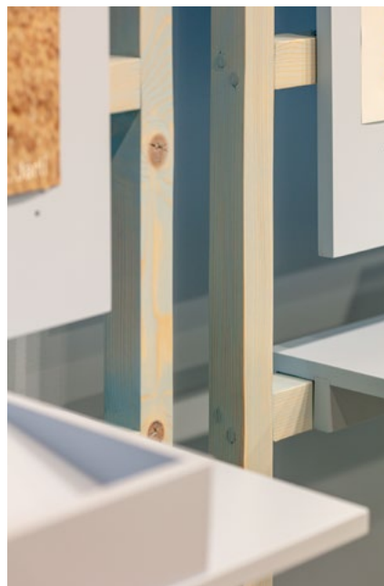
Da de ombrukte materialene var enkle i formatene var det viktig med en viss detaljeringsgrad for å heve uttrykket. En kombinasjon av malte og laserte overflater, plugging av skruerull og gjennomarbeidede løsninger og detaljer gir det hele et estetisk løft.
