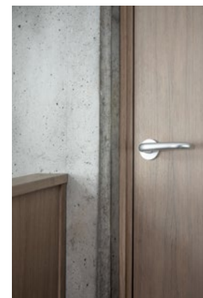
Karmer tegnet og produsert til veggens tykkelse med skjulte dørbeslag og dørvidere i rustfritt stål – som alle detaljer i villaen ellers.
