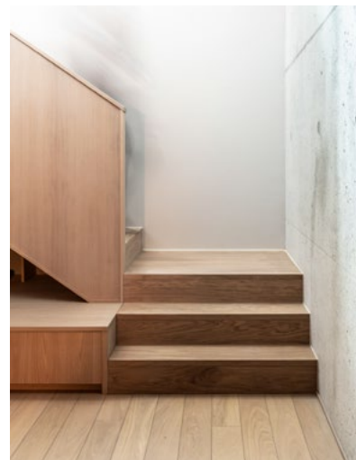
I underetasje ble det valgt en gulvbredde, materialtykkelse er samkjørt – som trappene, møbelskrog og rekkverksramme.
