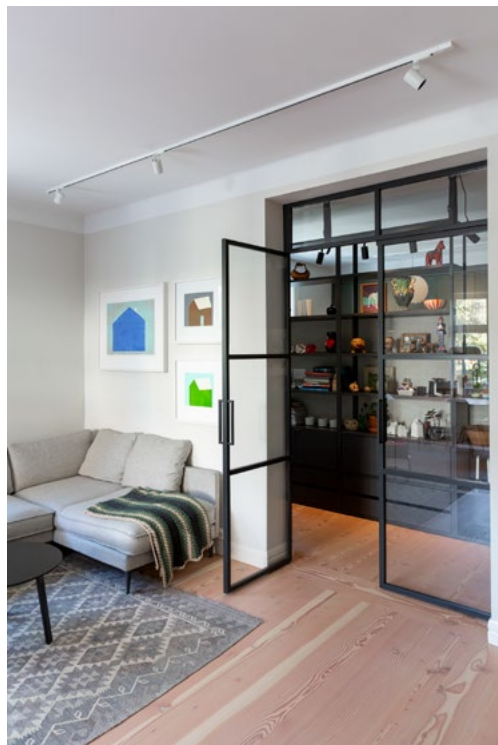
I den nye åpningen mellom soverom og stue ble det satt inn en tofløyet glass- og ståldør. Lukket eller åpen – stua oppleves mer luftig og rommet innenfor, før hylla, blir en del av stua
