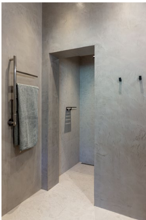
Det utvidede badet fikk mikrosement på alle vegger og en gulv- og veggflis i samme fargetone for å skape et harmonisk bad uten forstyrrende elementer.
