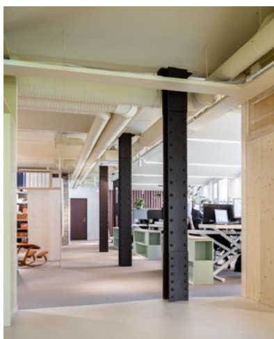
Kontor – vegger satt opp i et modulært system kalt Tewo Flex. På denne måten unngår man gips som må kastes når en eventuell ny leietaker skal overta lokalet.
