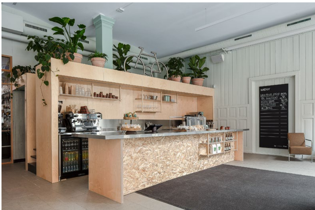
byMad – Det fantes allerede en mesanin i lokalet som ble tilpasset ønsket bruk. Man beholdt konstruksjonen, men kledde den på ny med tilgjengelig overskuddsmateriale.
