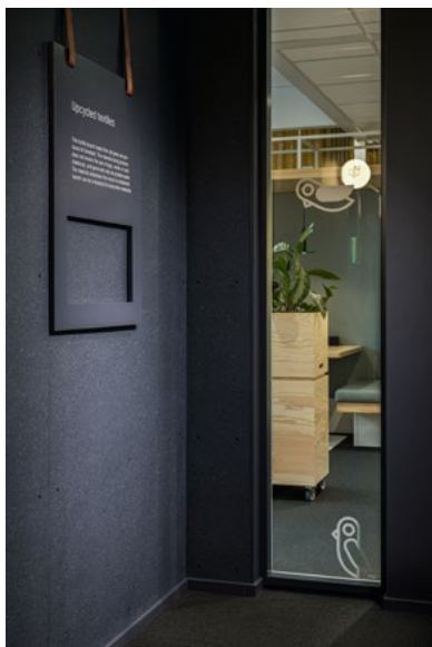
Veggene på innsiden av portalen har store partier kledd med Solid Textile Board fra Kvadrat. Disse er montert på vegger uten dørforbindelse og erstatter det siste laget med gips. Synlig innfesting gjør at platene enkelt kan demonteres og gjenbrukes.
