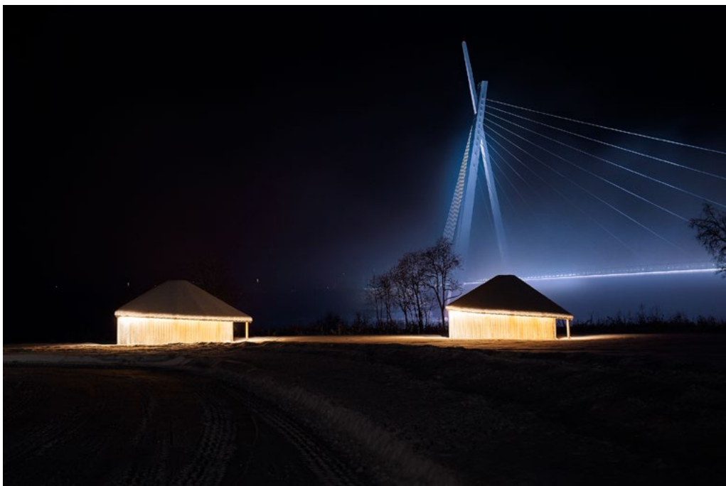
Ly gapahuk med nye Tana bro i bakgrunnen. Takformen er inspirert av brokonstruksjonen.
