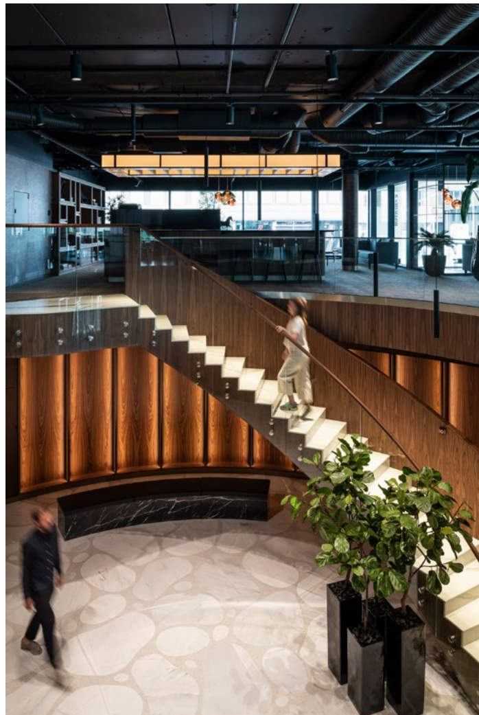
Trappen er byggets nye smykke, som leder opp til kaffebar, personalrestaurant og møtesenter. De buede veggene som omkranser inngangspartiet, kledd med valnøttfiner. Plassbygget buet benk.
